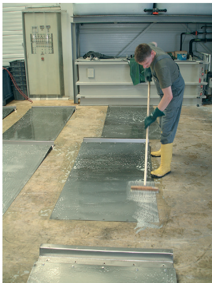
Auftragen und Einarbeiten von FR-D 50.
